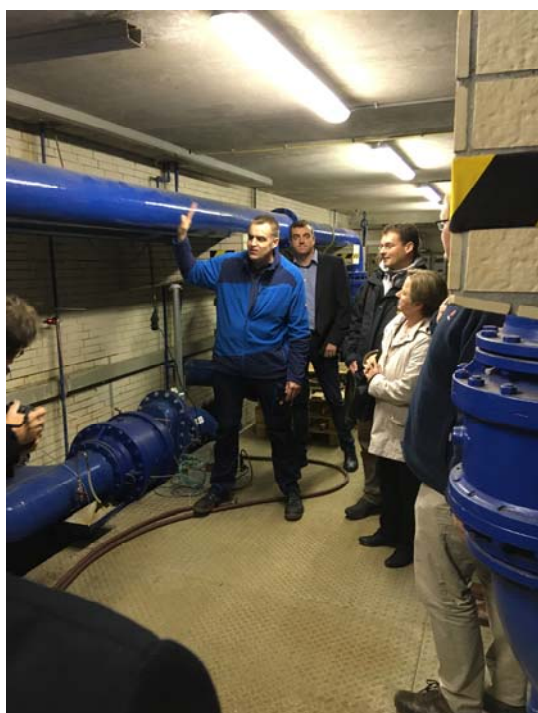
Führung durch das Wasserwerk / Rundvisning af vandværkerne
